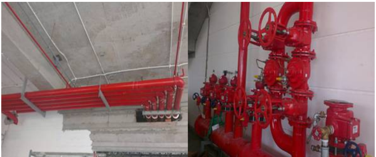
11. Nhà máy Điện Gió Bạc Liêu:
