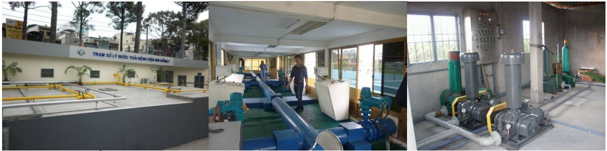
10. Dự án Đường ống PCCC Nhà máy P& G Dĩ An
